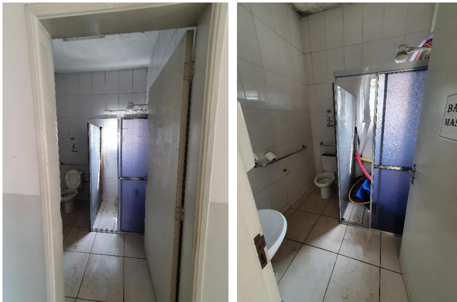
Figura 4-6 – Boxes dos banheiros a serem removidos
