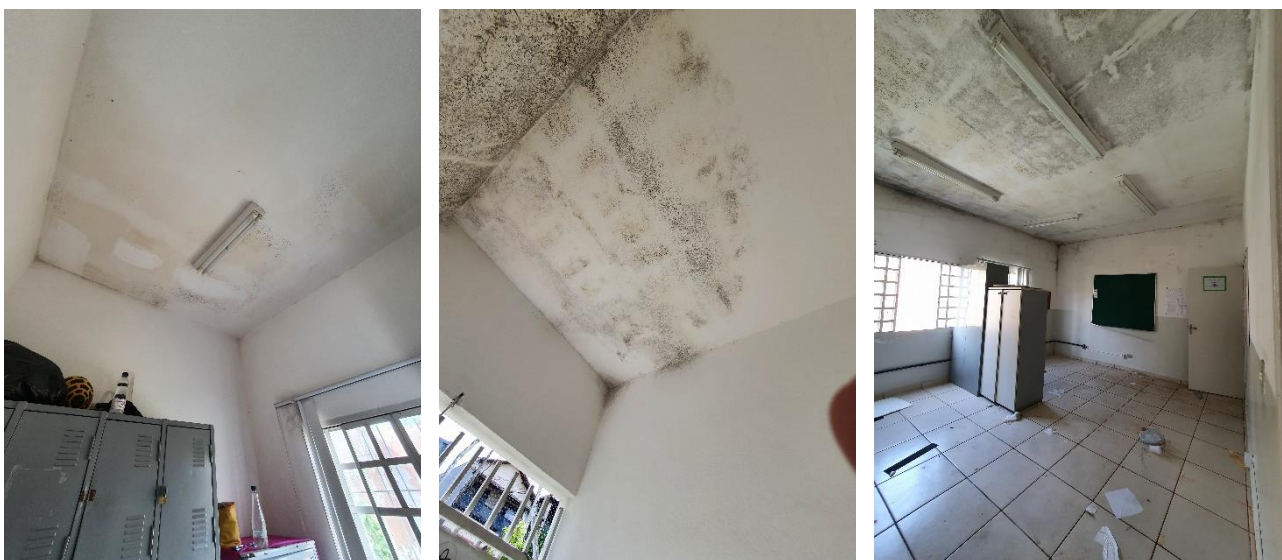
Figura 4-7 – Forro de gesso existente
