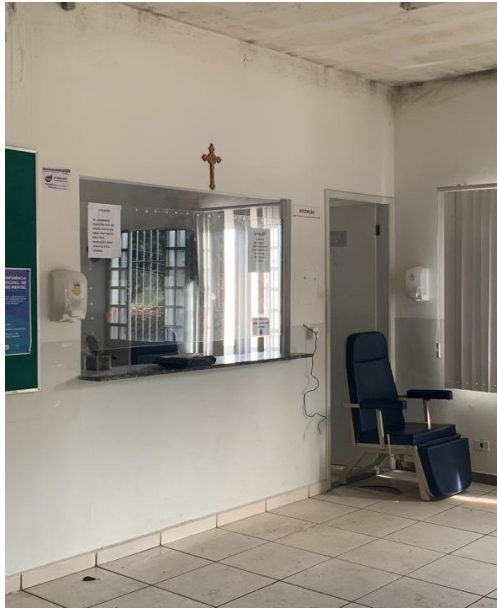
Figura 4-10 – Vidro a ser removido
