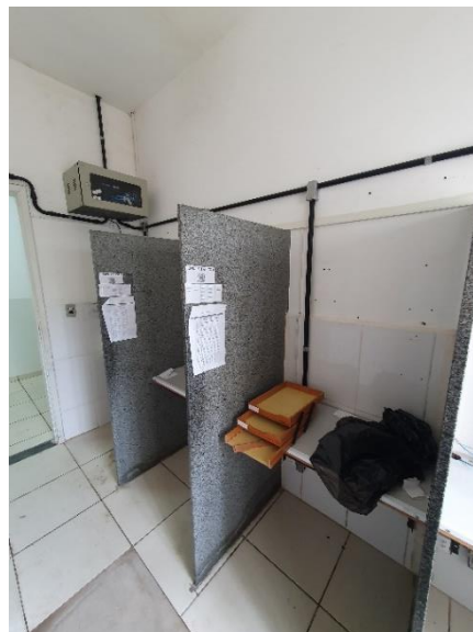
Figura 4-5 – Divisórias de granito a serem removidas
