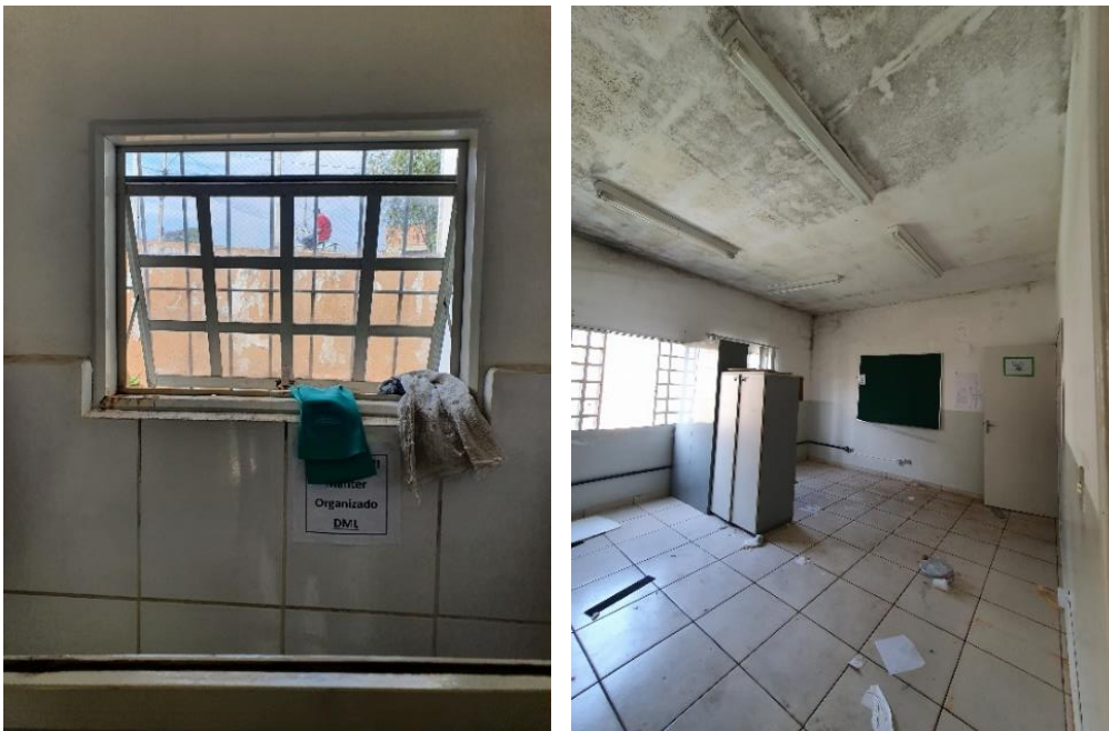
Figura 4-1 – Janelas do DML e Refeitório a serem removidas
